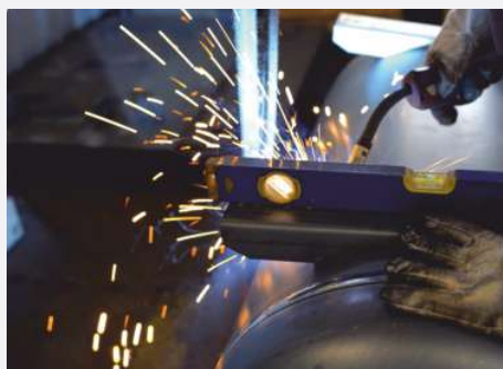
Цех емкостного оборудования
